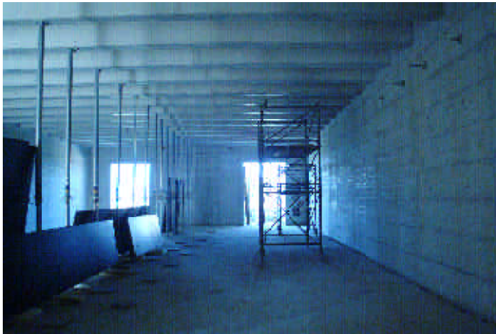
Blick in den großen Ausstellungsraum im Rohbau, Oktober 2004. Foto: Chris Korner, DLA.
